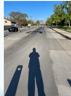
Permanent T-patch pavement on 3800 S.
